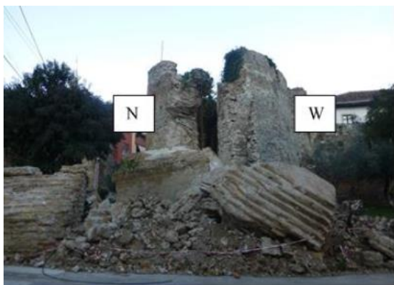
Fig. 9: Porta e shembur në kalanë e Durrësit pas tërmetit të 26 Nëntorit 2019 (Zona 5).
