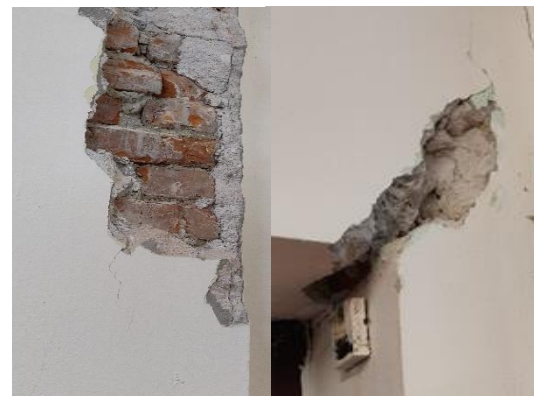
Fig. 3: Gjendja e muraturës së brendshme të objektit mbas tërmetit të 21 Shtatorit 2019 dhe tërmetit të 26 Nëntorit 2019
