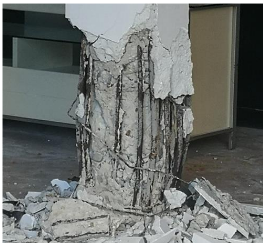
Fig. 7: Demtim strukturor në një ndërtesë betonarme (Zona 4)
