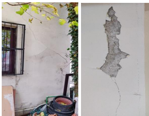
Fig. 4: Gjendja e muraturës së jashtme të objektit mbas tërmetit të 21 Shtatorit 2019 dhe tërmetit të 26 Nëntori 2019
